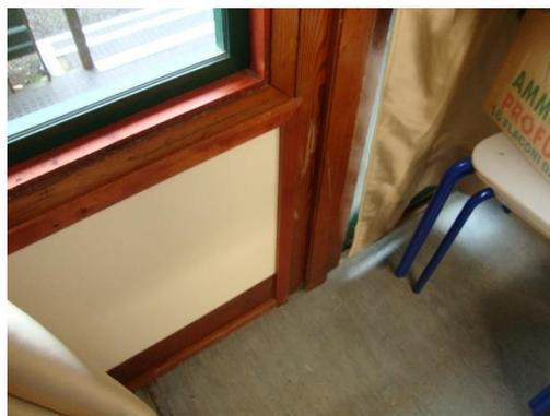
Questa soluzione realizzativa incide profondamente sul comportamento termico dell'edificio. La presenza di isolante riduce il fabbisogno termico della struttura con conseguenti minori consumi di combustibile.
